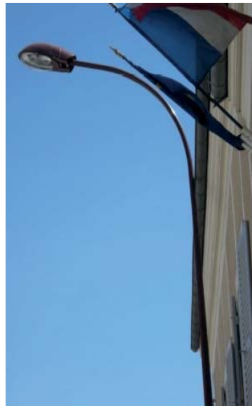
Eclairage public – rue de la Tuilerie (*)
