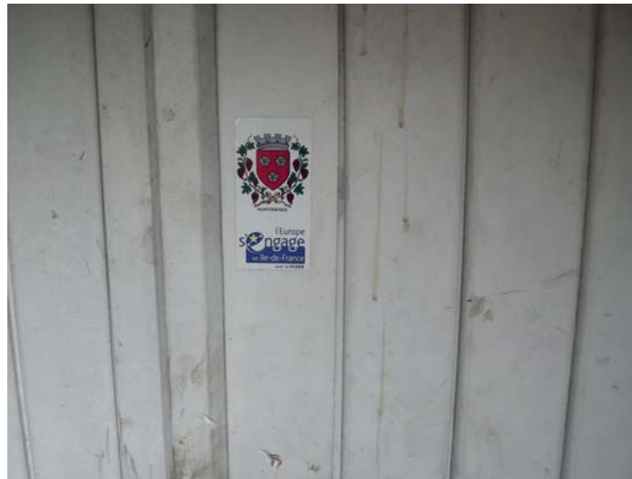
Communication à l'entrée de la chaufferie (*)
