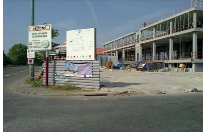
Pendant les travaux : vue du quai Voltaire (RD 311) (*)
