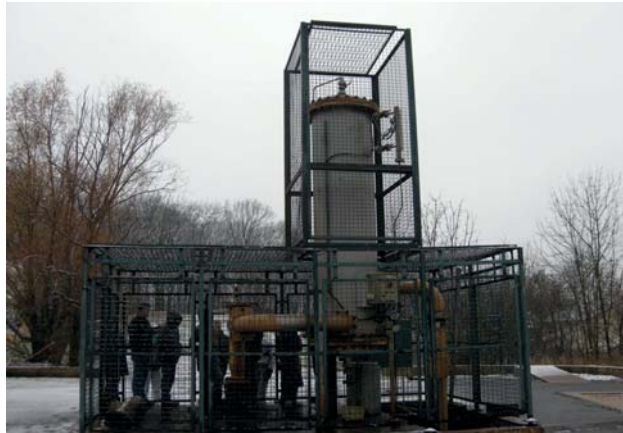
Puits de géothermie - Doublet (*)
