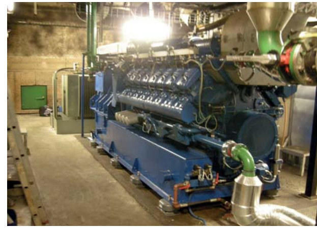
Moteur de cogénération (*)
