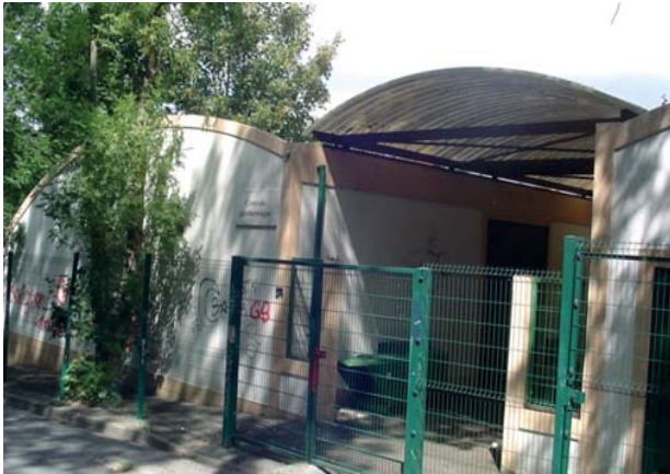
Centrale de géothermie (*)
