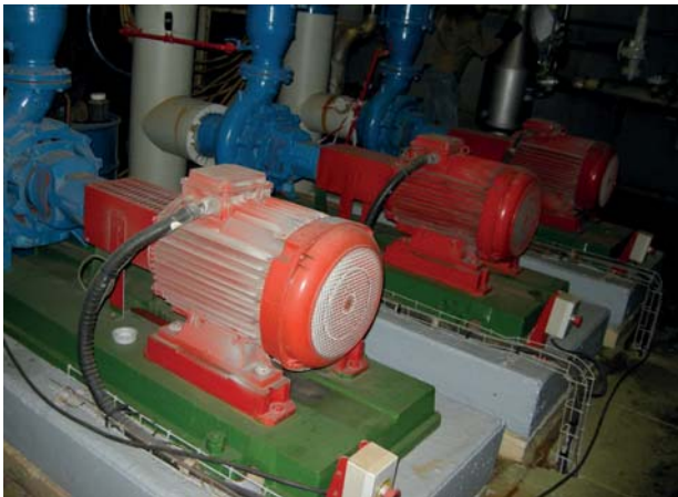
Moteurs d'échange calorifique permettant d'augmenter la température l'eau avant la distribution vers les abonnés par un système d'échange de chaleur par plaques (*)
