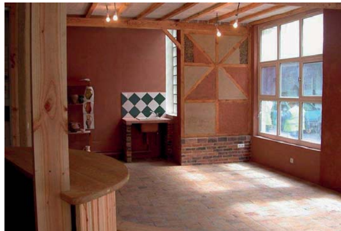
Chantier école éco-construction (⊞)
