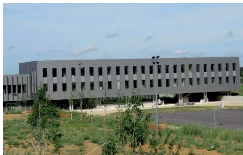
Après les travaux
