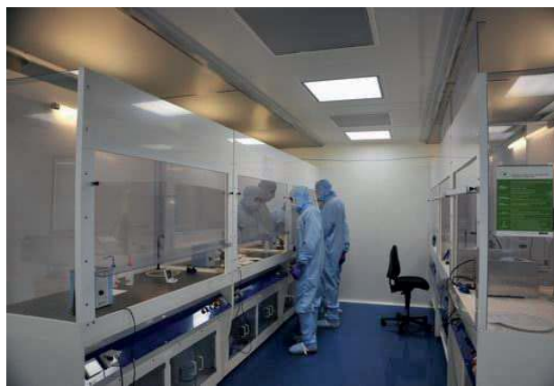
Zone de chimie avec 6 hottes à flux laminaires ISO 5 (*)
