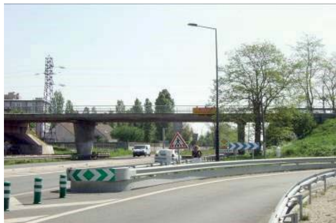
Vue du pont auquel sera adossée la future passerelle (*)
