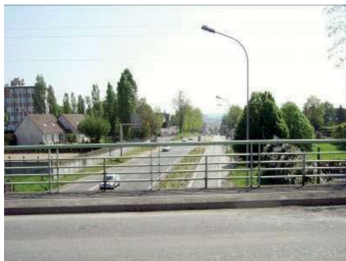
Vue vers la future passerelle (*)
