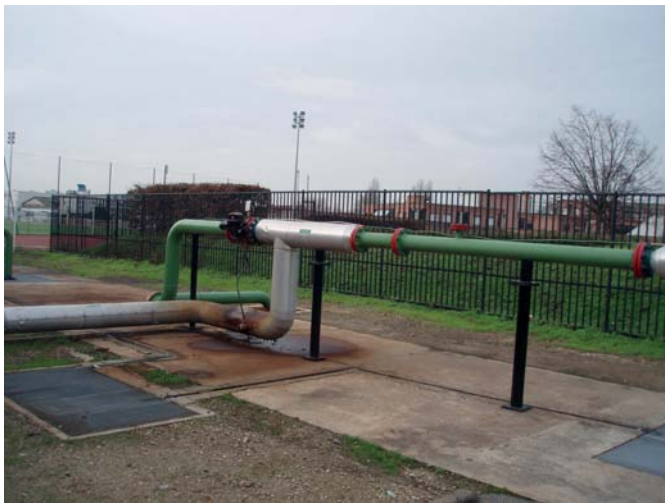
Station géothermique (La Courneuve) (*)
