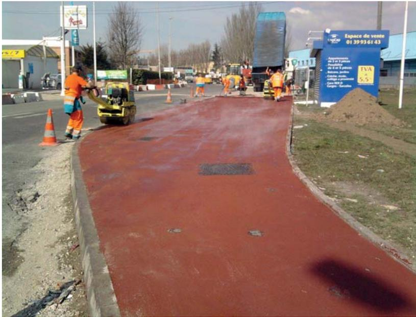
Technologies performantes en matière d'économies d'énergie et utilisation des matériaux recyclés et/ou recyclables : mise en œuvre de l'enrobé à liant végétal (\*)
